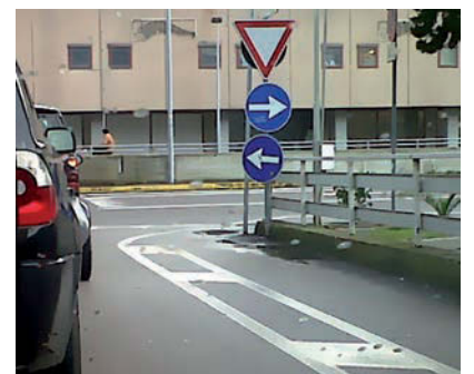
Fig. 5 Esempio di segnaletica verticale errata
