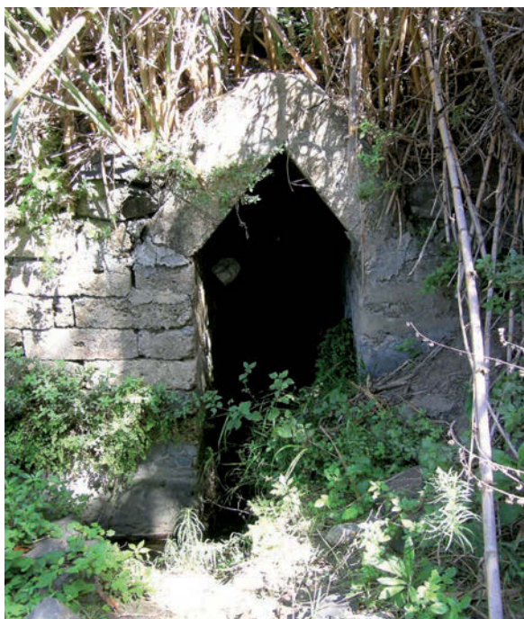
Galleria di captazione (Palagonia)
