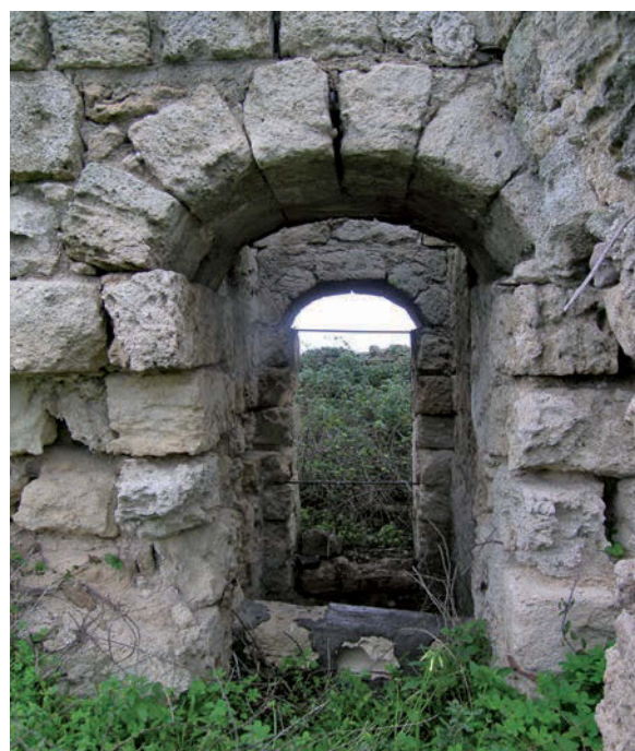
Struttura di protezione di un pozzo
