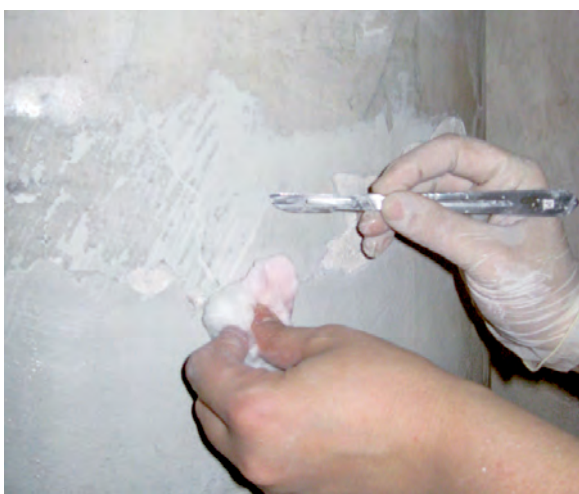
Fig. 12 Descialbo con bisturi su una colonna
