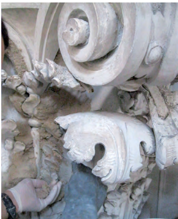
Fig. 15 Pulitura con impacchi di polpa di carta giapponese
