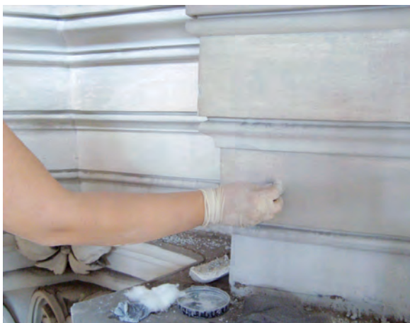
Fig. 11 Pulitura a tampone della trabeazione
