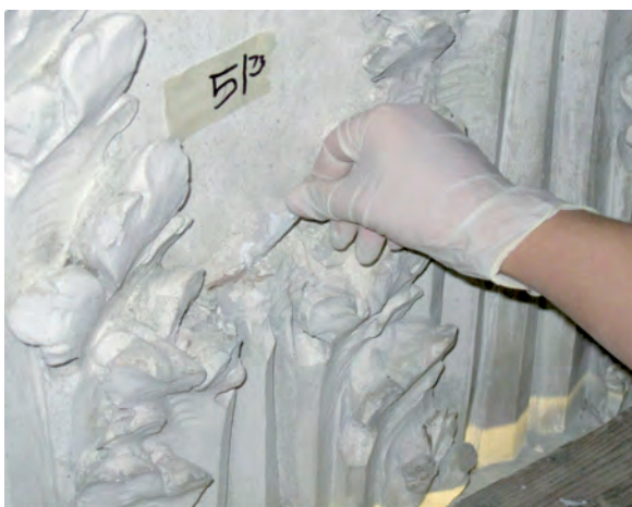
Fig. 14 Consolidamento e fissaggio di elementi a stucco distaccati
