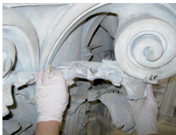
Fig. 13 Consolidamento e fissaggio di elementi a stucco distaccati
