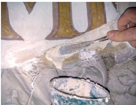
Fig. 16 Restauro di un cartiglio a stucco
