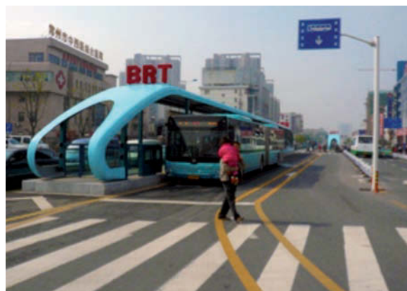
Fig. 4: Il BRT di Guangzhou (Cina)
