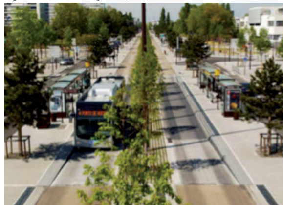
Fig. 5: La Busway di Nantes (Francia)
