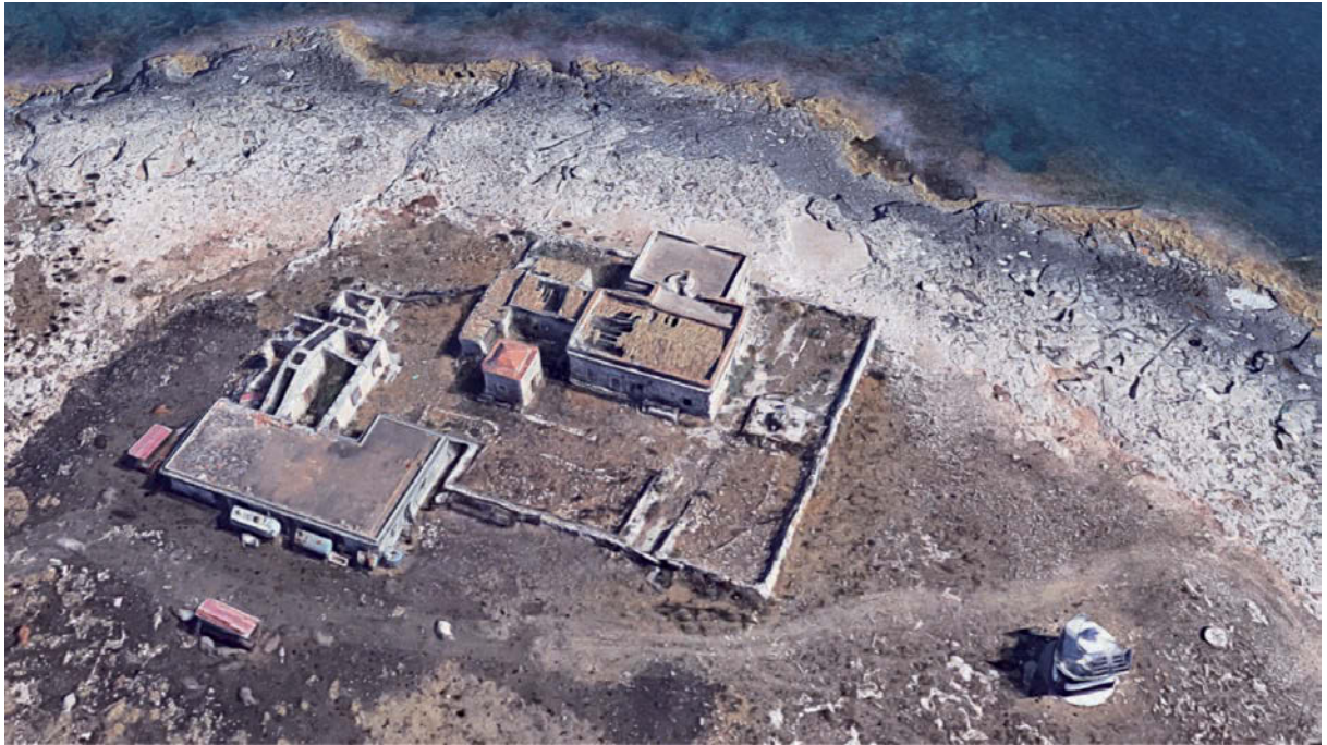
Figura -6 vista d'insieme dei fabbricati faro segnalamento e logistica annessi, fonte google maps.
