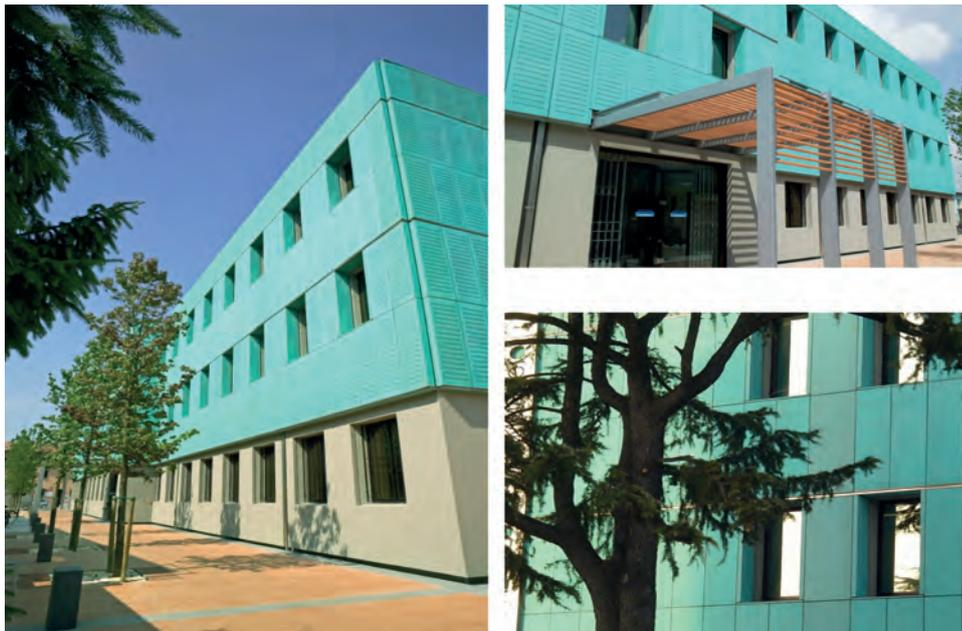
Fig. 7. Riqualificazione dell'involucro con l'uso di pareti ventilate. Sede ASCOM, Lugo (RA), 2005, progetto: STP Studio Alberto Piancastelli.
