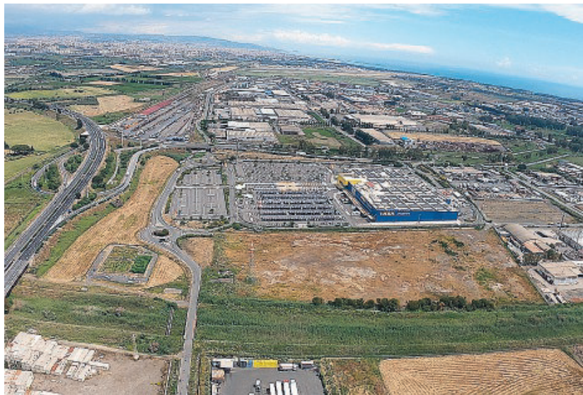
Una veduta aerea della Zona industriale
